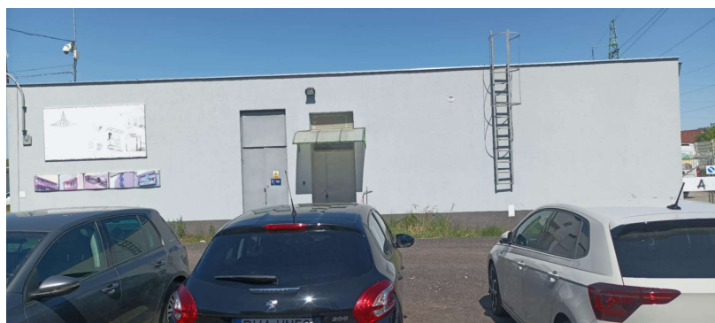
Widok stacji transformatorowej istniejącej – z zewnątrz
